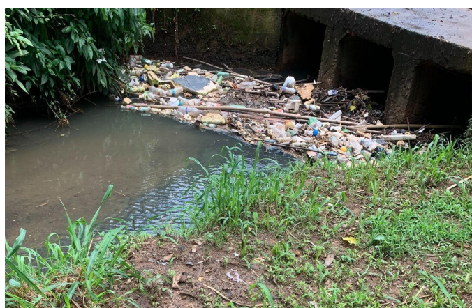
Figura 4 - Fotografia do córrego localizado na entrada do Parque da Cantareira. Autoria Própria
